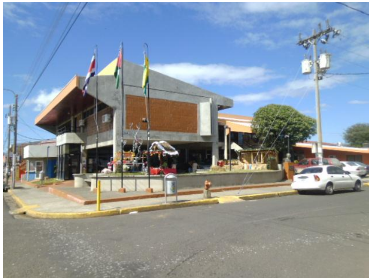
El Palacio Municipal se encuentra en el centro de Cañas frente al parque
