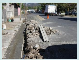
Además, con el fin de resguardar el estado de las bases del asfalto colocado que estaba sufriendo deterioro por la filtración de agua, se reconstruyeron 335 metros lineales de cordón y caño tipo L en mal estado, en los barrios El Castillo (código N° 506069) y San Martín (código N° 506069).
