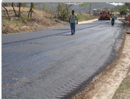
Arriba: se iniciaron las obras desde el entronque con la Ruta Nacional 142 (Polideportivo), Marzo 2010.
