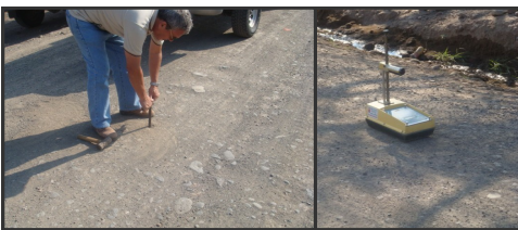
Arriba: Empresa contratada por la Municipalidad de Cañas, realiza pruebas de compactación, Marzo 2010.
