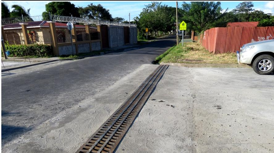
El proyecto consiste en la construcción de rellenos de aproximación en concreto y la confección y montaje de rejillas metálicas en entronques y cruces de algunas calles.
