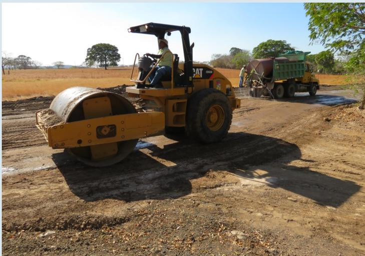
Se prosiguió con la ejecución de las actividades de excavación de sub rasante y colocación de material de relleno por sustitución en parte del camino vecinal entre Ruta N°1 (Hotel Capazurí) y las comunidades de Sandillal - Cedros.
