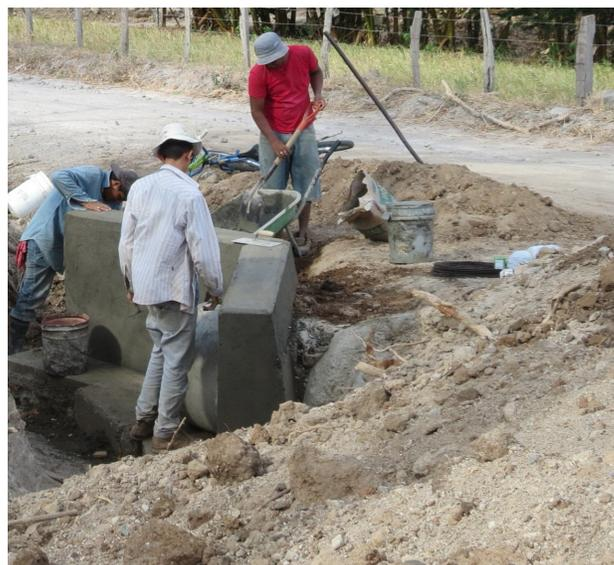
**D**e manera discontinua desde el 13 de febrero se ha estado trabajando en las actividades de colocación de pasos de alcantarilla de desagüe pluvial, así como en la construcción de cabezales en el camino vecinal N° 506022 entre Ruta N° 1 (Hotel Capazurí) y la comunidad de Sandillal.
