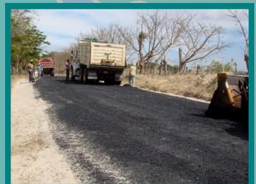
Fotos: se realizan las actividades de colocación de mezcla asfáltica. Palmira.
