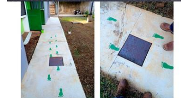
Inspecciones en el CECUDI
