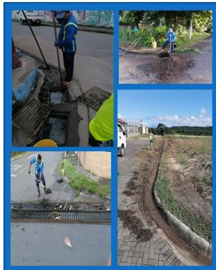
LIMPIEZA DE TRAGANTES Y ASEO DE VÍAS
