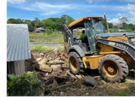
Obras de demolición-Reubicación de Santa Isabel Arriba
