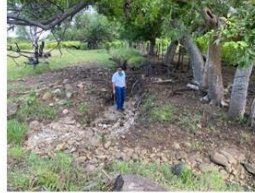
Inspecciones en temas de manejo de aguas pluviales
