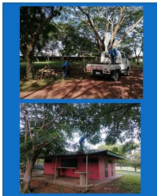
MANTENIMIENTO EN POLIDEPORTIVO
