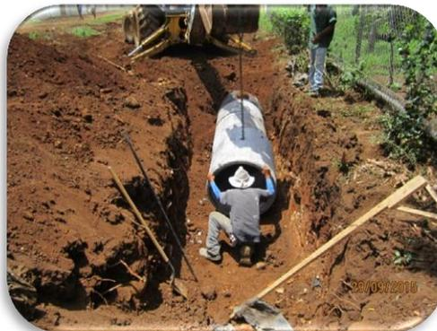
**Entubado de canal de desagüe pluvial en B° San Martín: 171 m de tubería,
