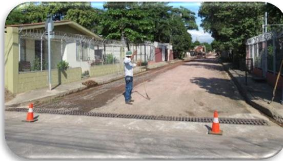
**Construcción de rejillas metálicas en vados: B° San Martín (4 und), B° Unión (2 und), B° El Castillo (1 und) y B° Los Ángeles (2 und)**
