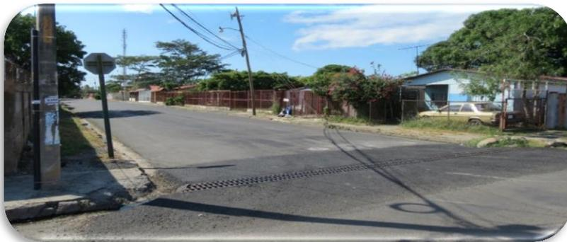
**Construcción de cuneta revestida y cordón y caño en Javilla: 175 m de cuneta y 176 m de cordón y caño.**
