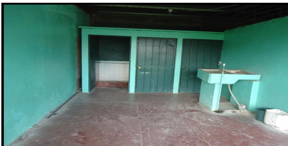
Reparación de Baños
